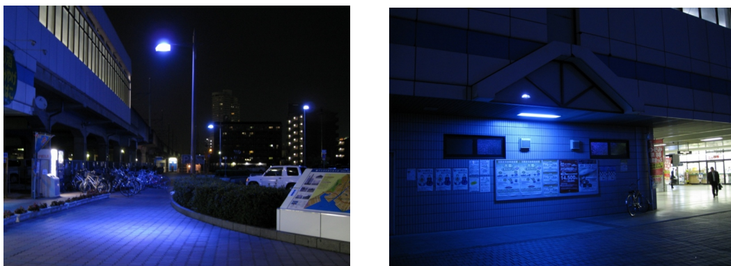
図 5.1.4 青色灯設置事例 (香川県宇多津町駅前広場)
