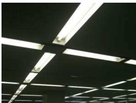
図5.2.7 天井取り付け時
