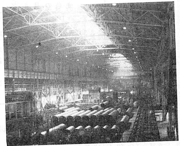
図2.5 高圧ナトリウムランプを採用した製鉄工場
