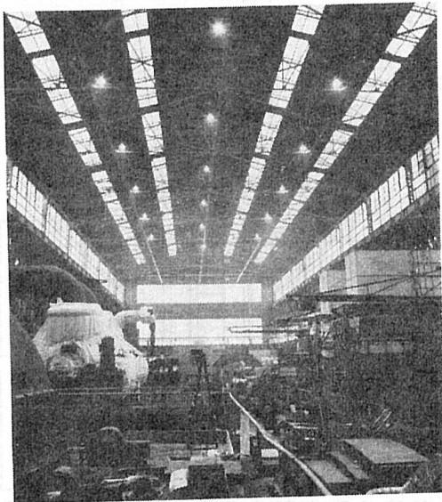
図2.4 高圧ナトリウムランプを採用した重電機工場
