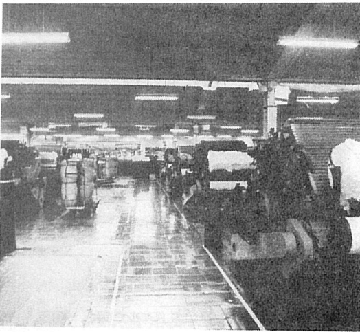
図 2.7 高効率蛍光灯器具を採用した機械工場
